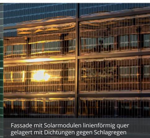
Fassade mit Solarmodulen linienförmig quer gelagert mit Dichtungen gegen Schlagregen
