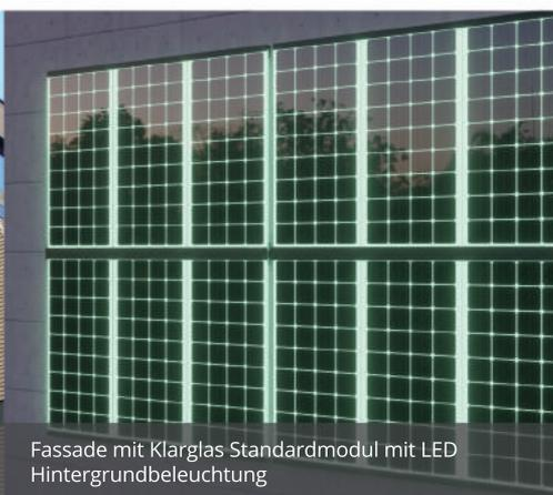
Fassade mit Klarglas Standardmodul mit LED Hintergrundbeleuchtung
