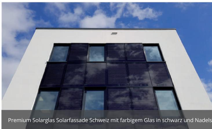
Premium Solarglas Solarfassade Schweiz mit farbigem Glas in schwarz und Nadelstreifendesign. Leistung pro m<sup>2</sup> 150 Watt als hinterlüftete Kaltfassade.
